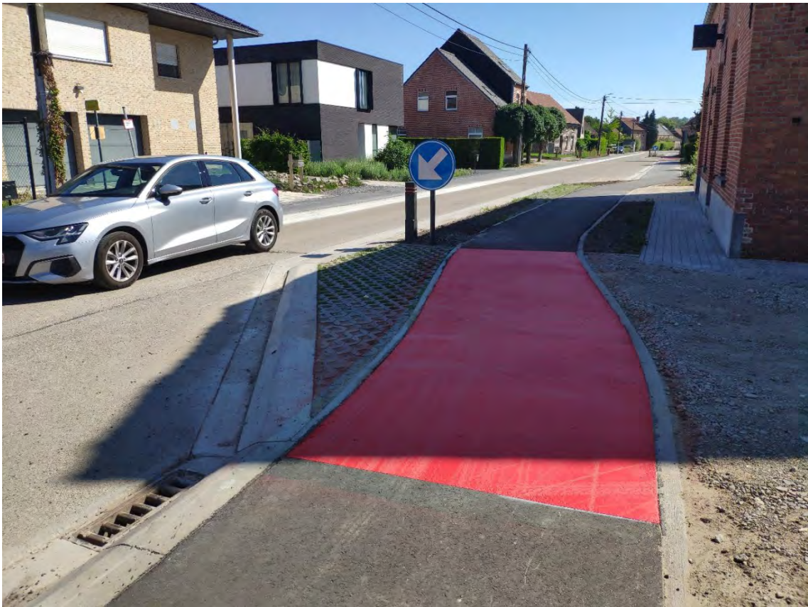
Figuur 50: Fietspad Hellichtstraat in Rotselaar
