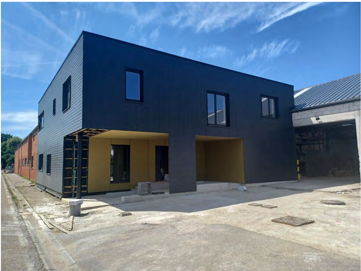
Figuur 45: Verbouwing gemeenteloods in Tremelo
