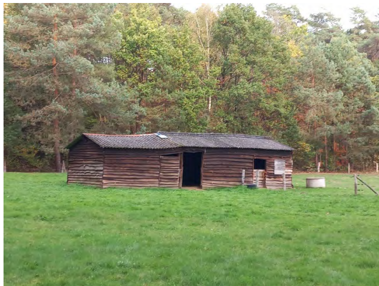
Figuur 12: Asbestdak
