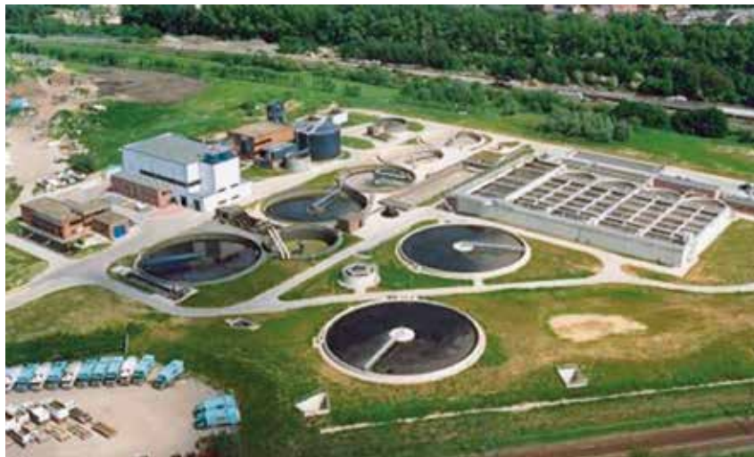
Het beluchtingsbekken van het waterzuiveringsstation bij Leuven. © Aquafin.
