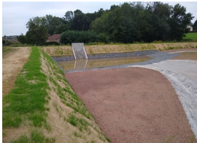
Aanleg bufferbekken bedrijventerrein Keiberg-Vossem Tervuren
